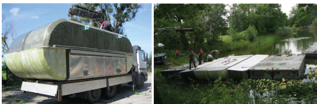
Rys. 8. Transport segmentu oraz budowa przeprawy w połączeniu z segmentami PP-64
