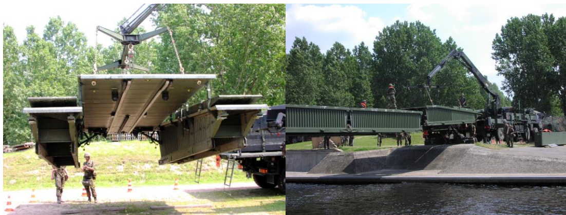
Rys. 1. Montaż mostu DoFB, segment najazdowy w trakcie podnoszenia i układanie segmentu na przęsło pomocniczym [12]
