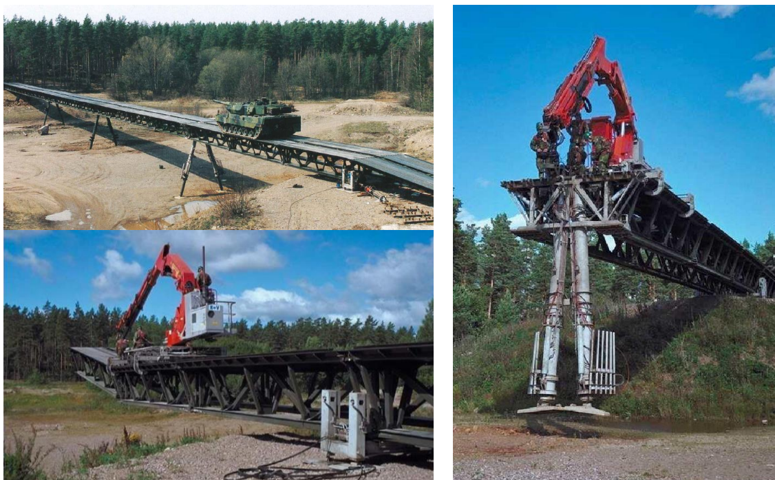
Rys. 8. Most FB 200 na przeszkodzie terenowej i widok wspornikowego montażu segmentów przęsła i podpory za pomocą specjalnego układacza [17]
