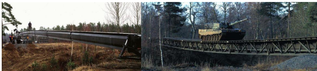
Rys. 6. Widok wysuniętego na przeciwległy brzeg blachownicowego przęsła pomocniczego i kompletnego mostu FB 48 na przeszkodzie (między kratowymi dźwigarami przęsła pomocnicze) [17]
