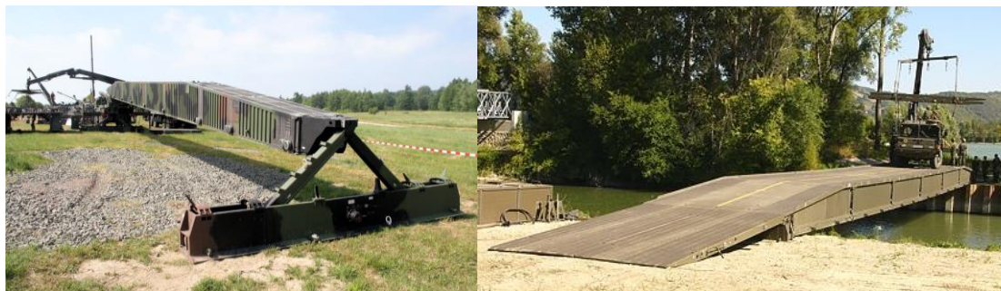
Rys. 2. Przęsło pomocnicze z belką brzegową i gotowy most z najazdem [12]
